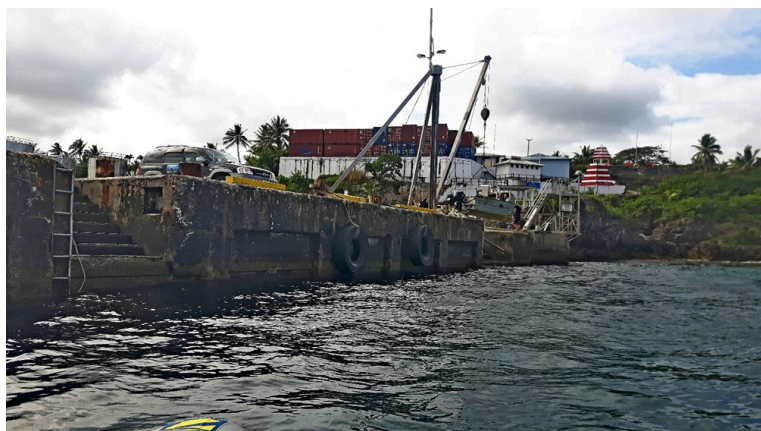
Figura 27: Il pontile di approdo di Niué con la gru per issare i canotti
